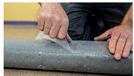
Beim Schnellverlegesystem norament nTx ist der Belag bereits werksseitig mit einer Kleberückseite versehen.
